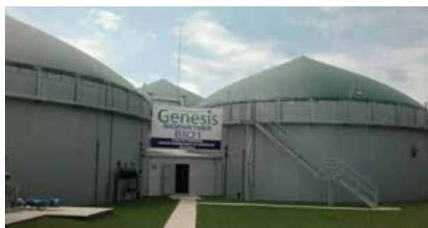
Fig. 30. Stația de biogaz din județul Prahova, România
