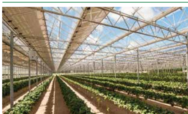
Fig. 29. Seră cu utilizarea panourilor solare
