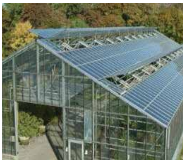
Fig. 59. Seră cu utilizarea colectoarelor solare
