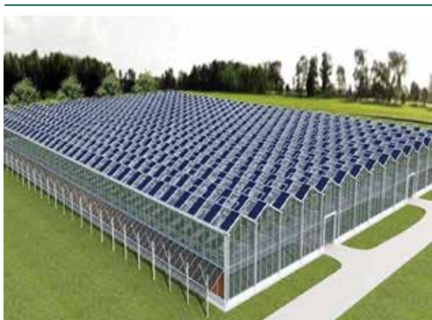
Fig. 57. Seră agricolă cu panouri fotovoltaice
