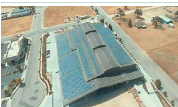
Fig. 28. Sistemul fotovoltaic de la Crama San Antonio
