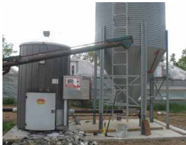
Fig. 20. Cazan de ardere a boabelor de porumb conectat cu siloz de alimentare
