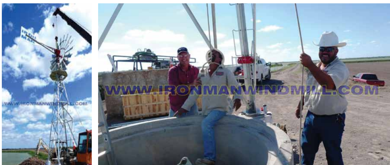
Fig. 24. Pompa eoliană din Harlingen District
