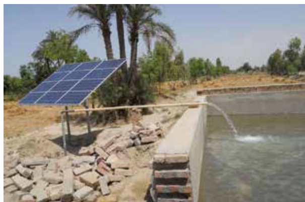
Fig. 26. Utilizarea panourilor fotovoltaice pentru pomparea apei
