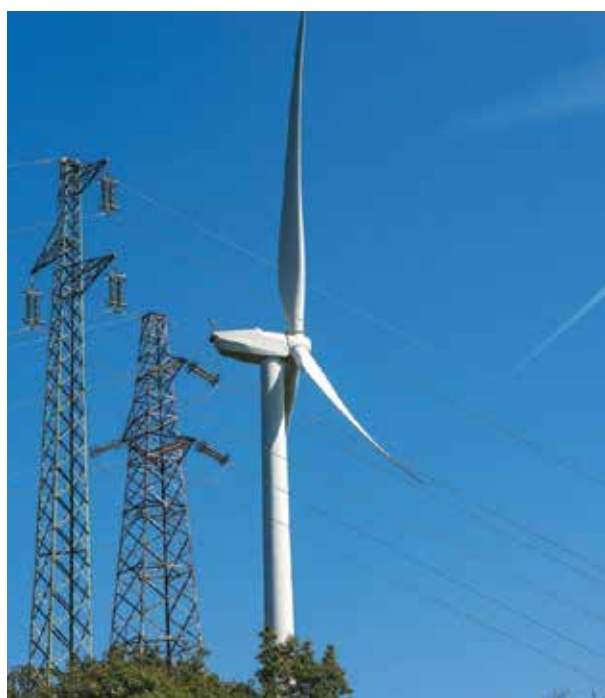
Fig. 56. Turbină eoliană conectată la rețea
