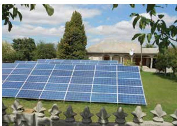
Fig. 40. Amplasarea panourilor fotovoltaice pe suprafețe plane – sol
