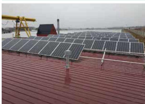
Fig. 41. Amplasarea panourilor fotovoltaice pe suprafețe plane – acoperișuri
