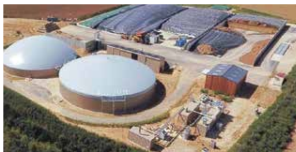
Fig. 31. Stația de biogaz din Senlis, regiunea Picardie
