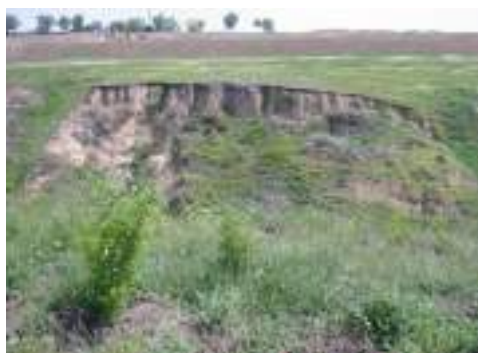
Fig. 7. Alunecare de teren provocate de ploile torențiale din anul 2010
