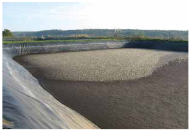
Fig. 3.41. Rezervor – batal pe bază de geomembrană pentru stocarea dejecțiilor lichide
