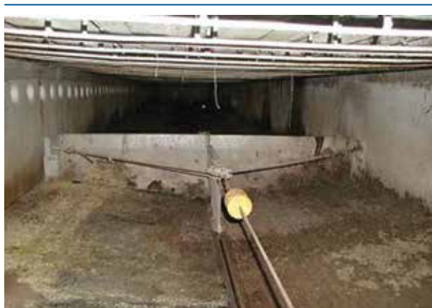
Fig. 5.31. Racletă mecanică de colectare a dejecțiilor de porcine
