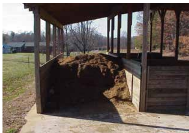
Fig. 6.50. Depozit individual acoperit pentru depozitarea dejectiilor.
