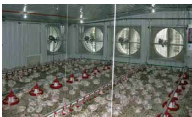
Fig. 6.46. Sistem de ventilare forțată în hală
