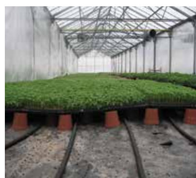
Fig. 2.96. Utilizarea furtunului de tip Geopal pentru încălzirea solului în sere: aspect furtun (stânga), amplasarea pe sol (centru) și la creșterea răsadului în palete celulare (dreapta).
