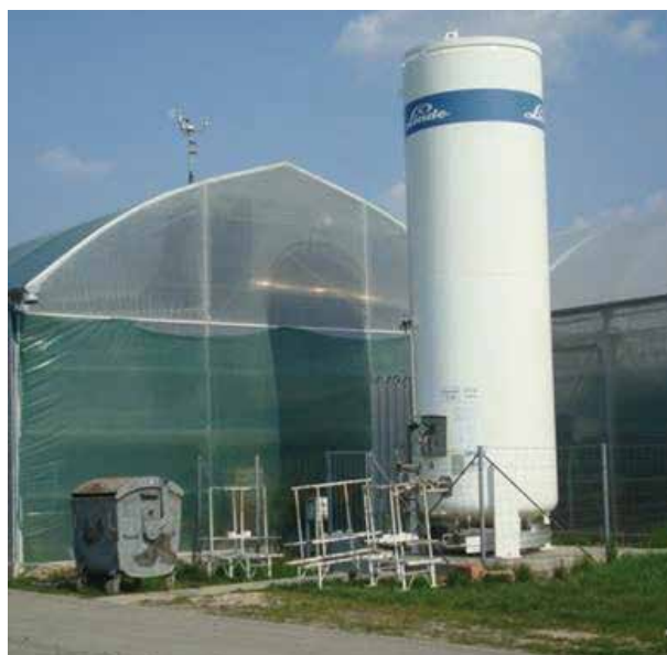
Fig. 2.105. Sistem automatizat de dozare CO 2 în seră
