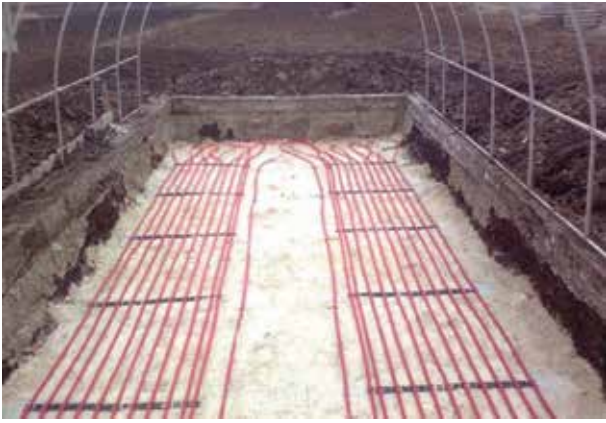
Fig 2.88. Încălzire subterană (stânga) și cu conducte la nivelul solului (dreapta) Sursa: https://roomgood.ru
