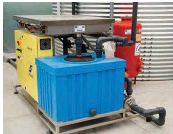
Foto 4. Unitate de filtrare și sterilizare UV
