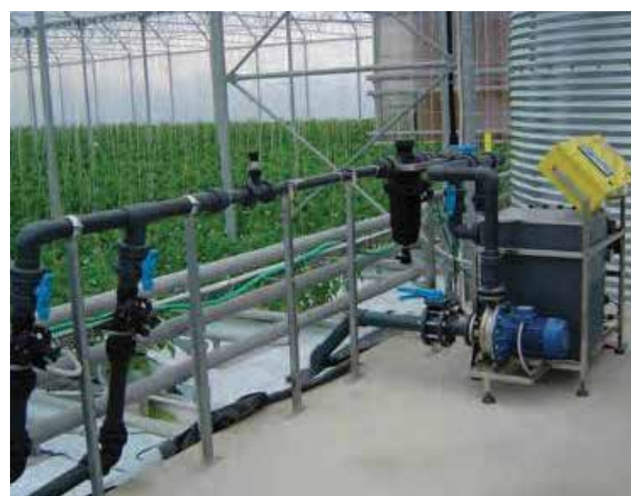
Foto 3. Instalație autonomă pentru prepararea și distribuția soluției nutritive
