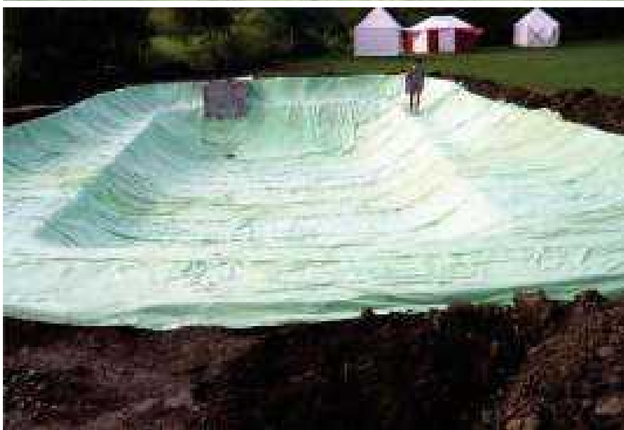
Fig. 3.11-3.12. Construcția unui iaz pluvial
