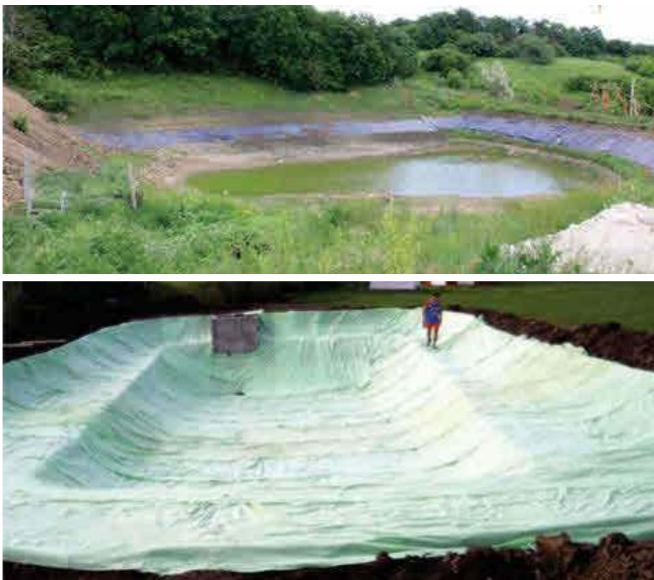
Fig. 5.11-5.12. Construcția unui iaz pluvial
